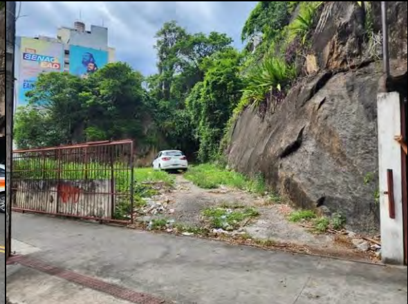
Entrada do Terreno avaliando, na R. Dr. Eurico de Aguiar
