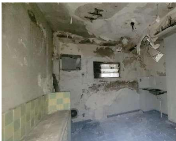
Figura 47 – Vista pavimento térreo
