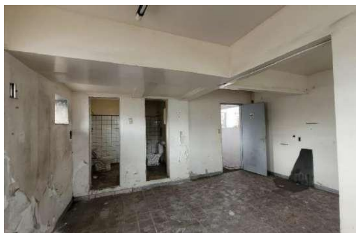
Figura 38 – Sala segundo pavimento
