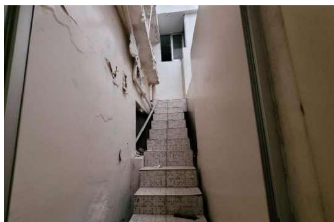
Figura 46 – 2º acesso ao primeiro pavimento
