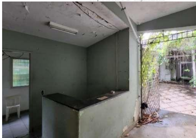
Figura 15 – Vista interna edificação
