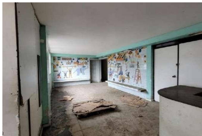
Figura 44 – Recepção pavimento térreo
