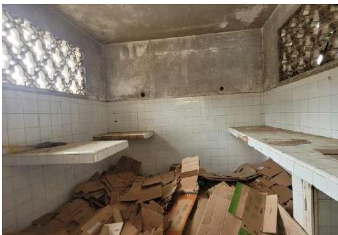
Figura 64 – Vista interna edificação 2
