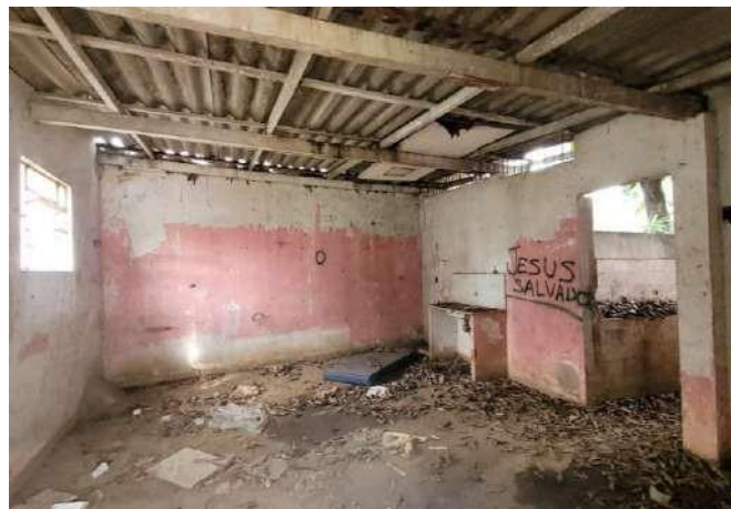
Figura 62 – Vista interna edificação 2
