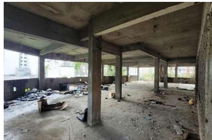
Figura 26 - Vista pavimento térreo
