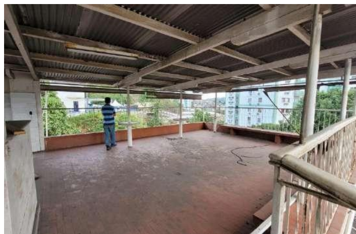
Figura 40 – Vista terceiro pavimento
