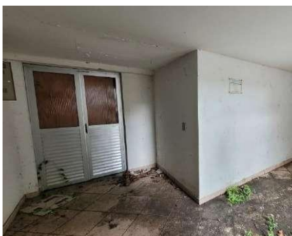
Figura 27 – Vista pavimento térreo
