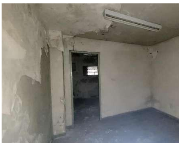
Figura 45 – Sala pavimento térreo
