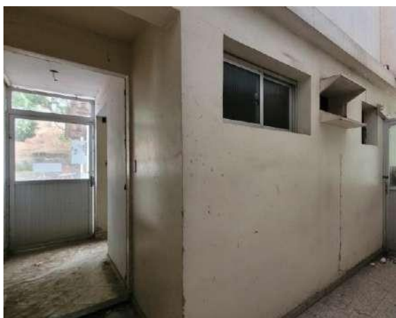
Figura 49 – Vista pavimento térreo
