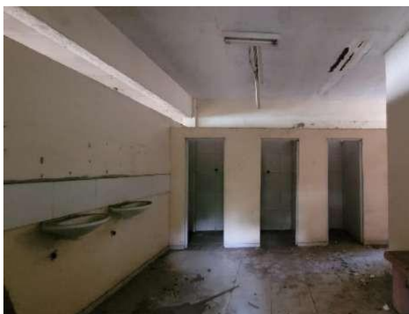
Figura 25 – Banheiro pavimento térreo
