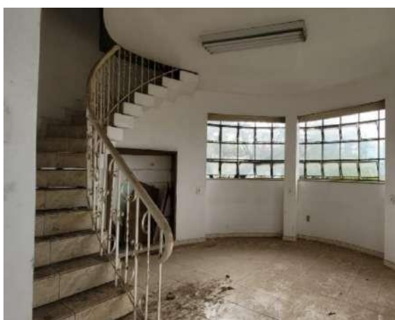
Figura 57 – Acesso ao terceiro pavimento
