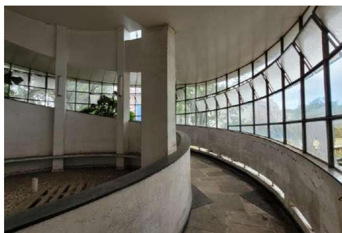
Figura 50 – Rampa de acesso aos pavimentos
