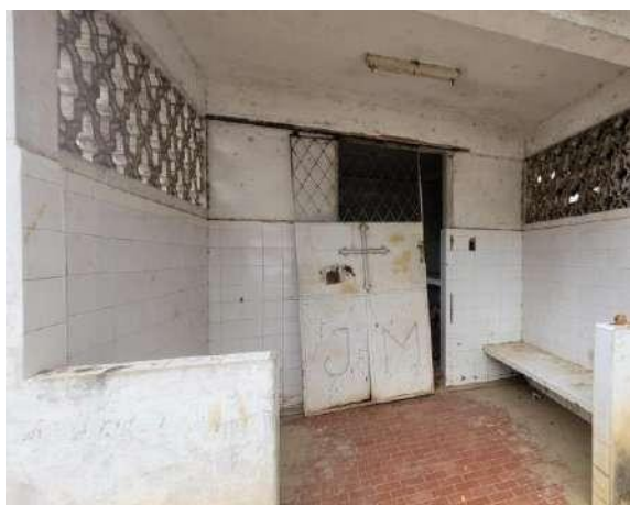
Figura 63 – Vista interna edificação 2
