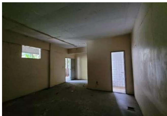
Figura 19 – Sala pavimento térreo
