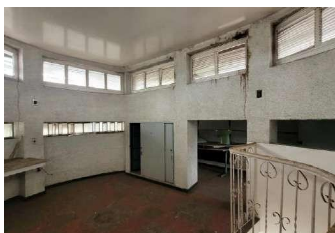
Figura 58 – Vista terceiro pavimento
