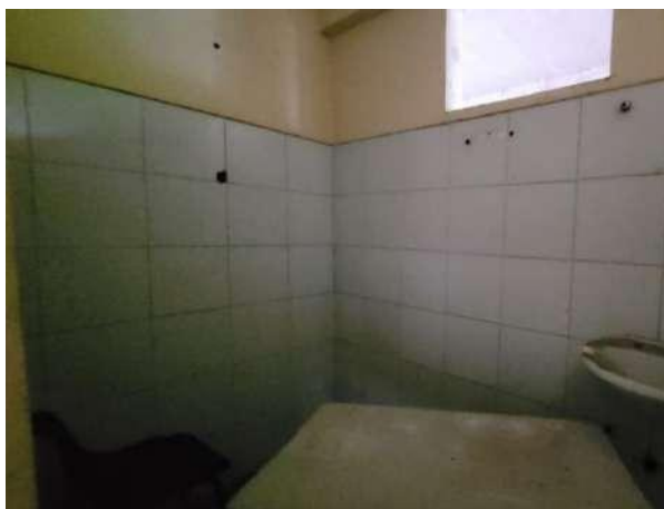
Figura 20 – Banheiro sala pavimento térreo
