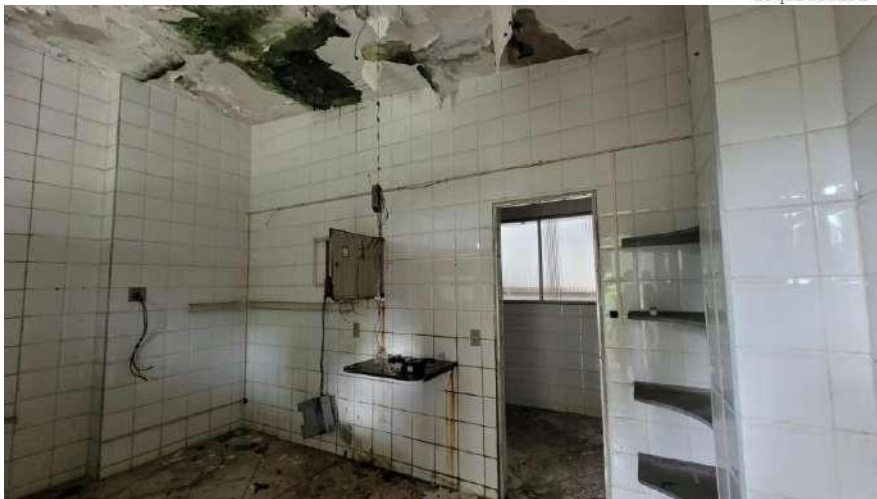
Figura 5 – Cozinha – 2º pavimento
