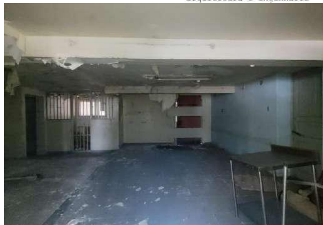
Figura 60 – Vista pavimento térreo
