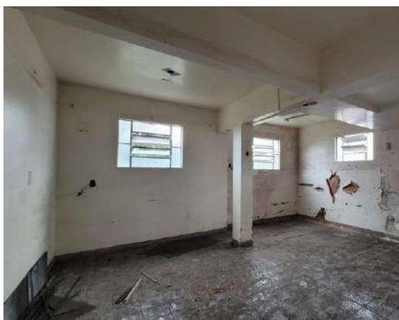
Figura 37 – Sala segundo pavimento
