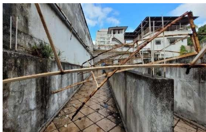
Figura 28 – Acesso ao primeiro pavimento
