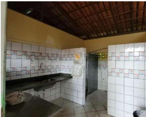
Figura 14 – Vista interna edificação
