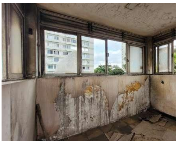
Figura 41 – Vista terceiro pavimento
