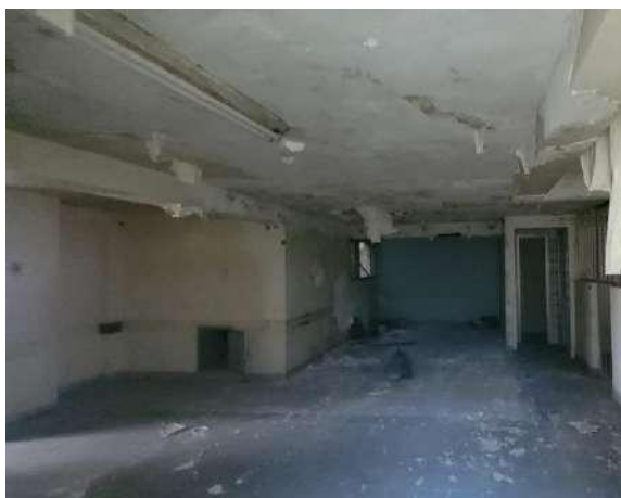
Figura 59 – Vista pavimento térreo
