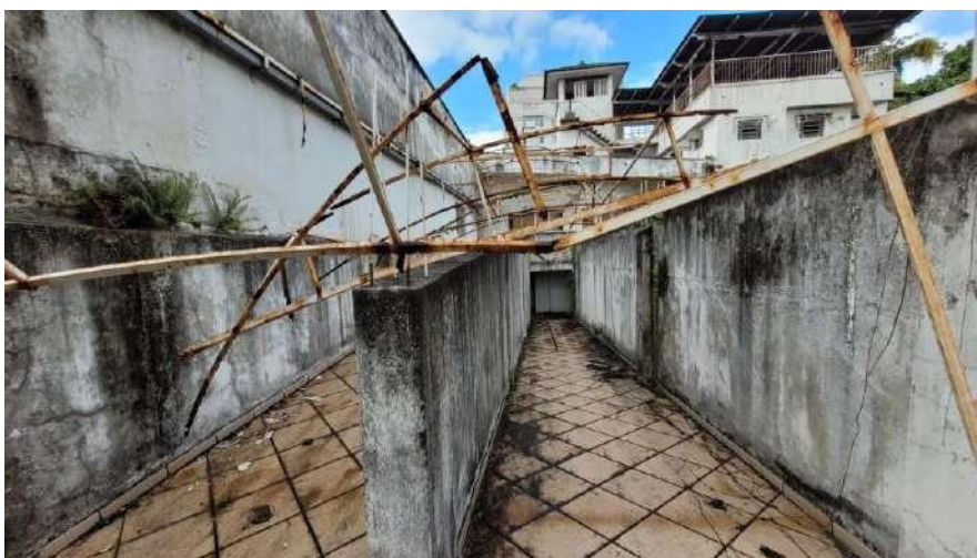
Figura 4 – Rampa de acesso ao 2º pavimento
